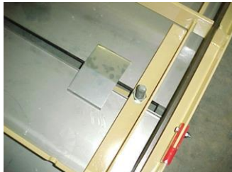
Bandeja deslizante de acero inoxidable p/derrames de electrolito
