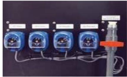
El MWTS utiliza cuatro productos químicos: Hidróxido de sodio (cáustico), MetalEX, sulfato de aluminio (alumbre como coagulante) y polímero. Se utilizan bombas de inyección de químicos de velocidad ajustable para inyectar los químicos en el tanque de tratamiento.
